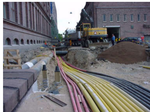
Yhteisrakentamistyömaa Finlayssonin edessä
